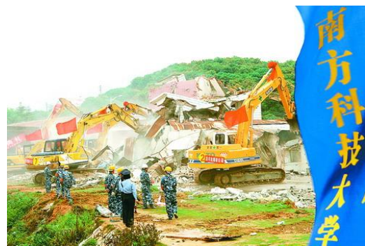
建设中的南方科技大学 (《深圳商报》记者 林勤 摄)
